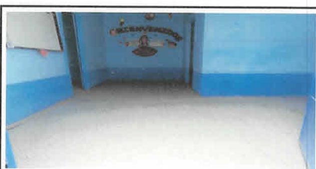
Foto 6: Piso de granito colocado en direccion.
