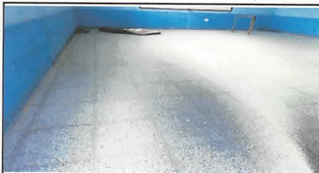
Foto 3: piso de granito colocado en aula.
