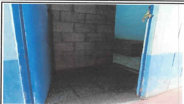
Foto 2: Baño de niños habilitado, paredes construidas, puertas instaladas, piso de granito instalado, migtorio y lavamanos construido.
