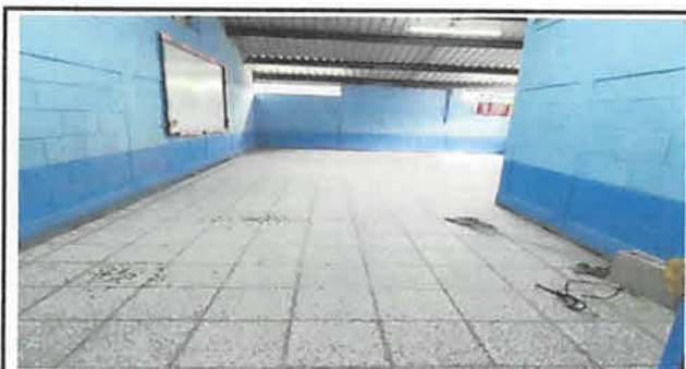
Foto 5: piso de granito colocado en aula.
